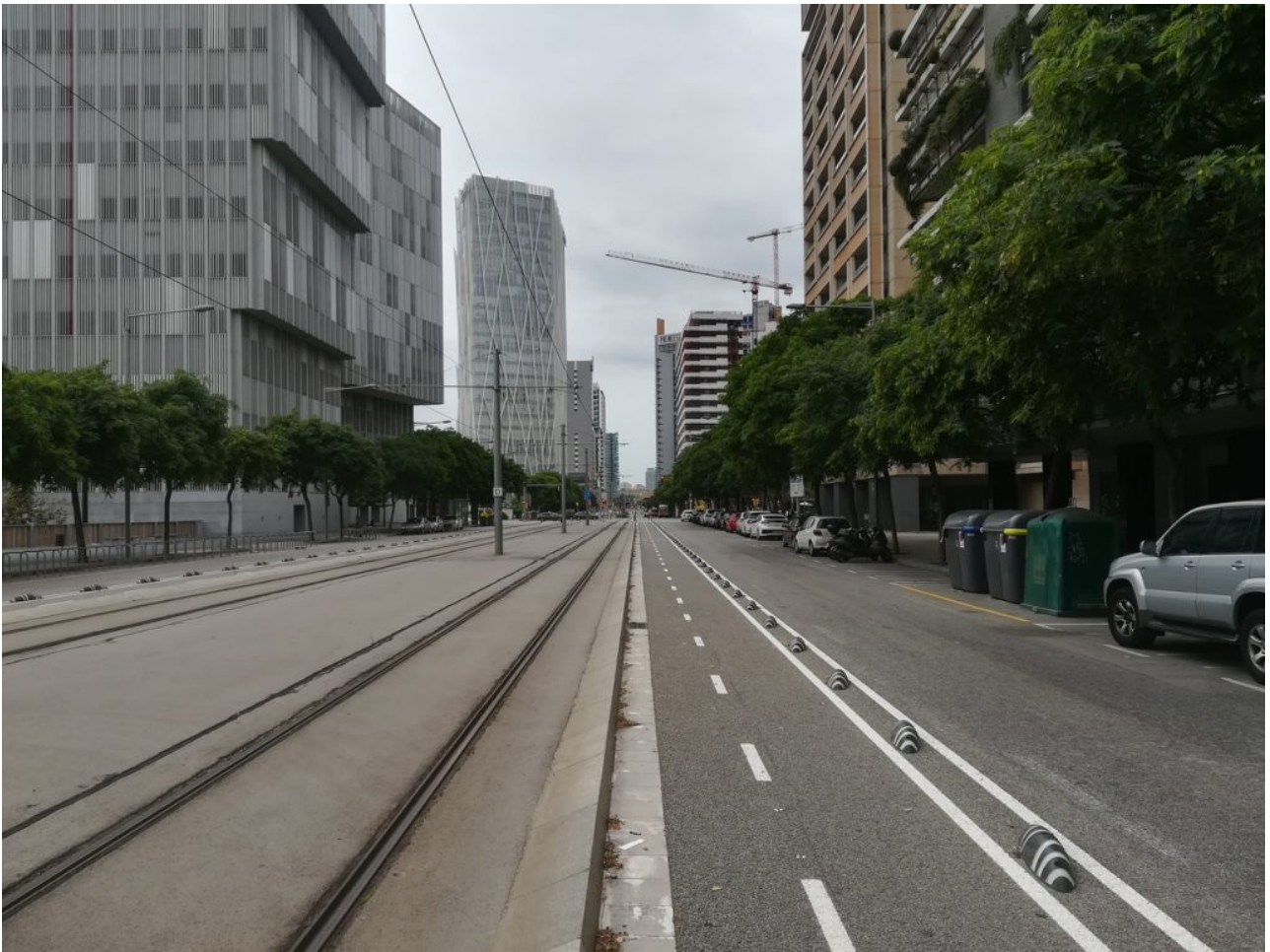
Aménagement cyclable, deux voies dans le même sens (pour doubler), et idem de l'autre côté de la voie de tram
