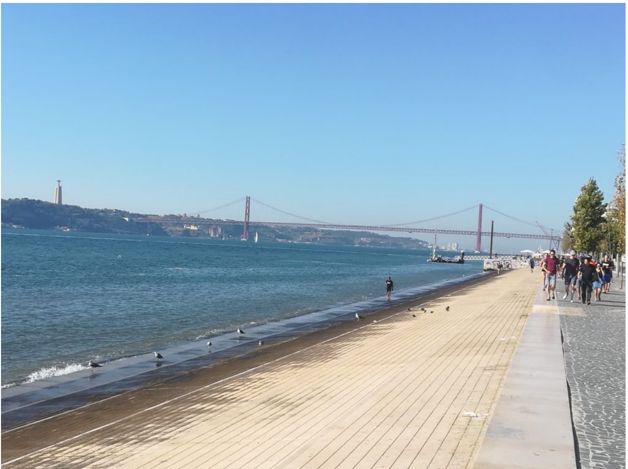
Le Tage, avec le pont permettant de relier les deux rives, Lisbonne en rive droite, Cacilhas en rive gauche.
