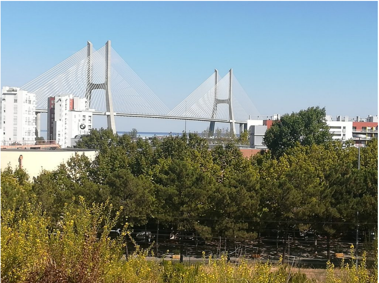
Le début du pont Vasco de Gama, côté nord.
