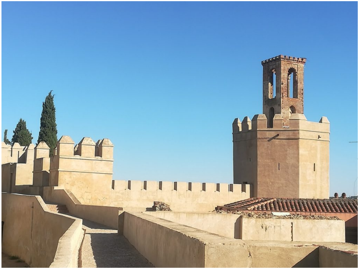
La Tour d'Espantaperros. C'est une des composantes du système défensif de l'alcazaba de Badajoz, un fort almohade datant du XII e siècle. Il s'agit d'une tour albarrane, c'est-à-dire établie au devant de l'enceinte, à laquelle elle est rattachée par un arc, facile à détruire en cas d'attaque. Ce type de fortifications est caractéristique de l'Espagne musulmane.
