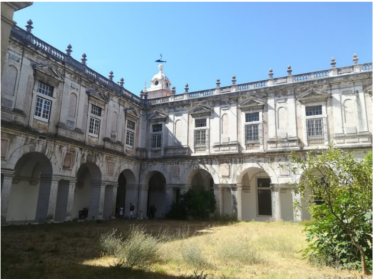
Cloître du couvent de Grâce (en cours de rénovation).
