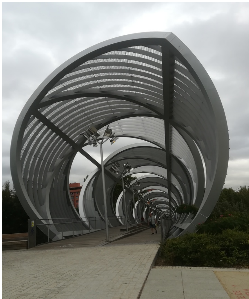
Superbe passerelle piétons-cycle sur le roi Manzanarès.
