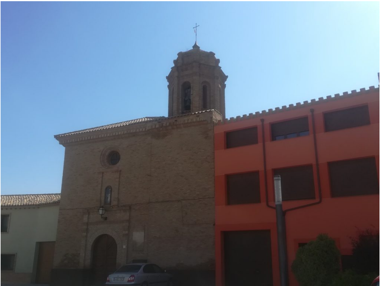
Église de Figueruelas, coïncée entre deux maisons.
