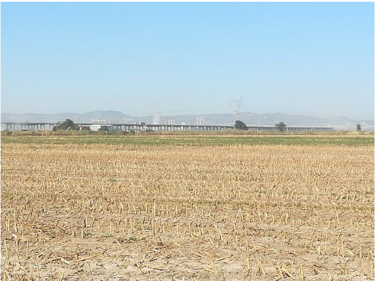
Autoroute sur pilotis, dans la très large vallée du Tage.
