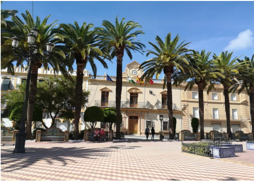
Bâtiment public à Ayamonte.
