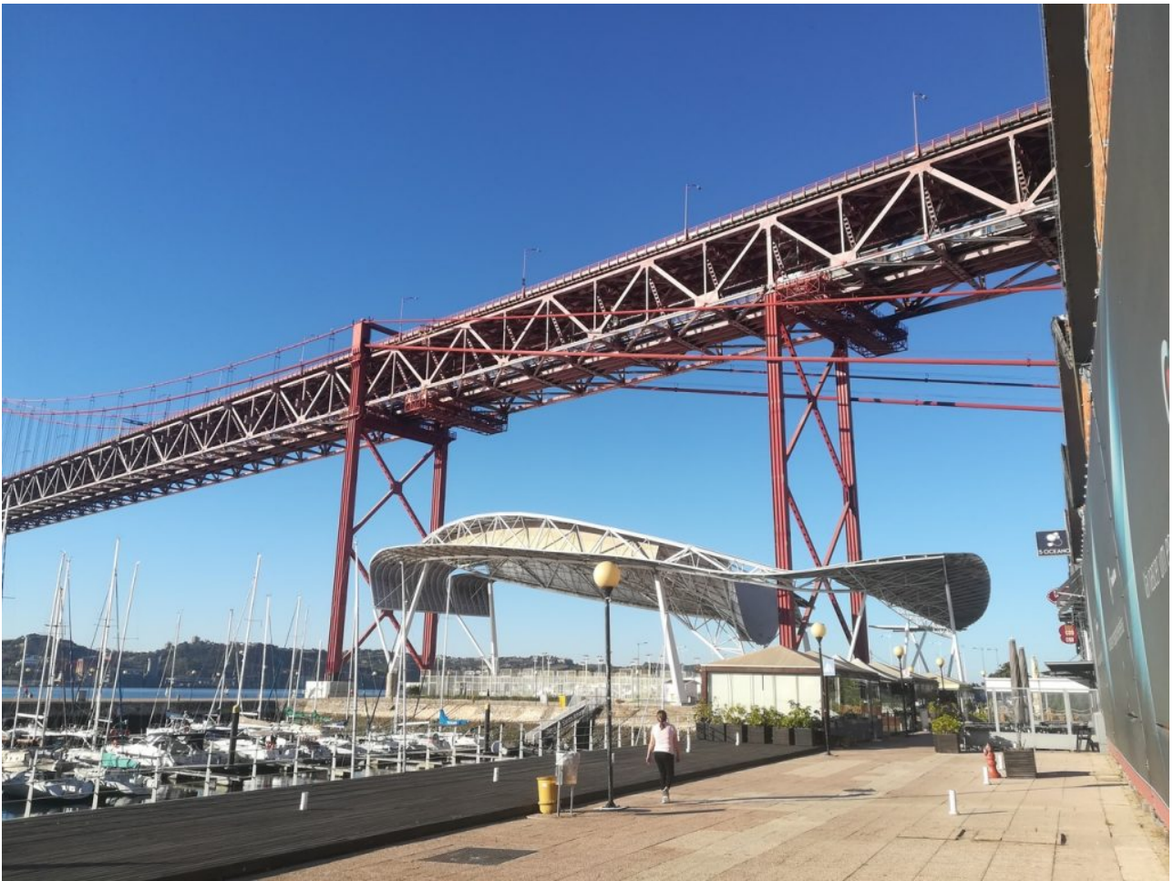
Le pont du 25 avril. La voie supérieure, c'est l'autoroute, mais à l'étage en-dessous, c'est la ligne de chemin de fer
