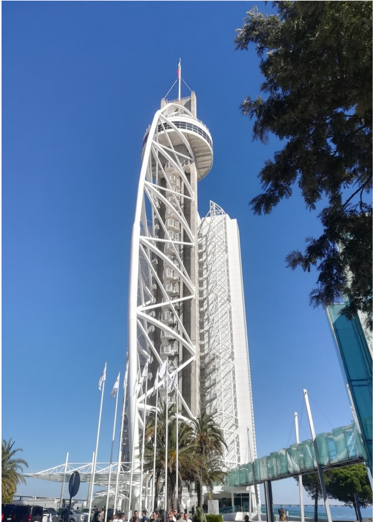
La tour Vasco de Gama.(145 mètres, le plus haut bâtiment de Lisbonne) au parc des Nations. Aujourd'hui, un hôtel est adossé à cette tour construite pour l'exposition universelle de 1998.
