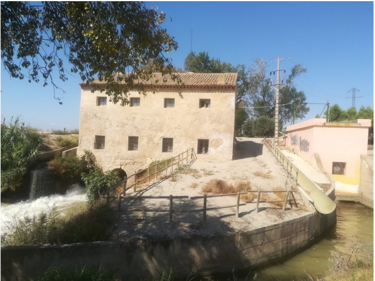
Le moulin de Tauste, à gauche le vieux moulin, à droite sur le canal d'évitement, une turbine pour fabriquer de l'électricité.
