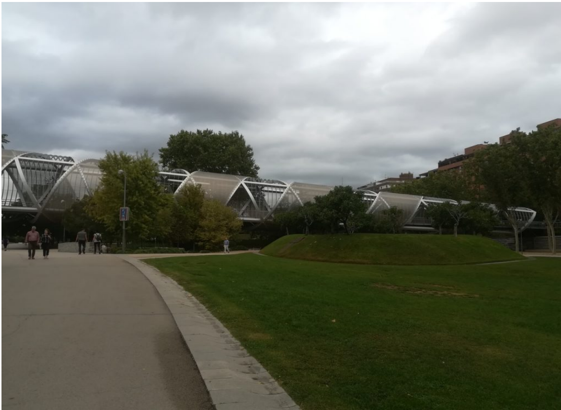
Superbe passerelle piétons-cycle sur le rio Manzanarès. Vue très partielle, on voit la moitié d'un tube, et il se prolonge pas un deuxième tube. Superbe !!! et très fonctionnel.
