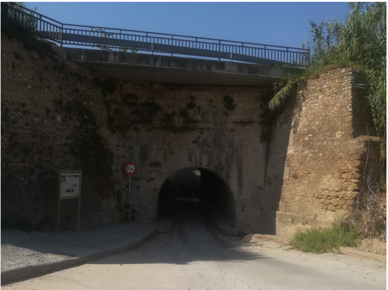
Vieux tunnel à Figueruelas.
