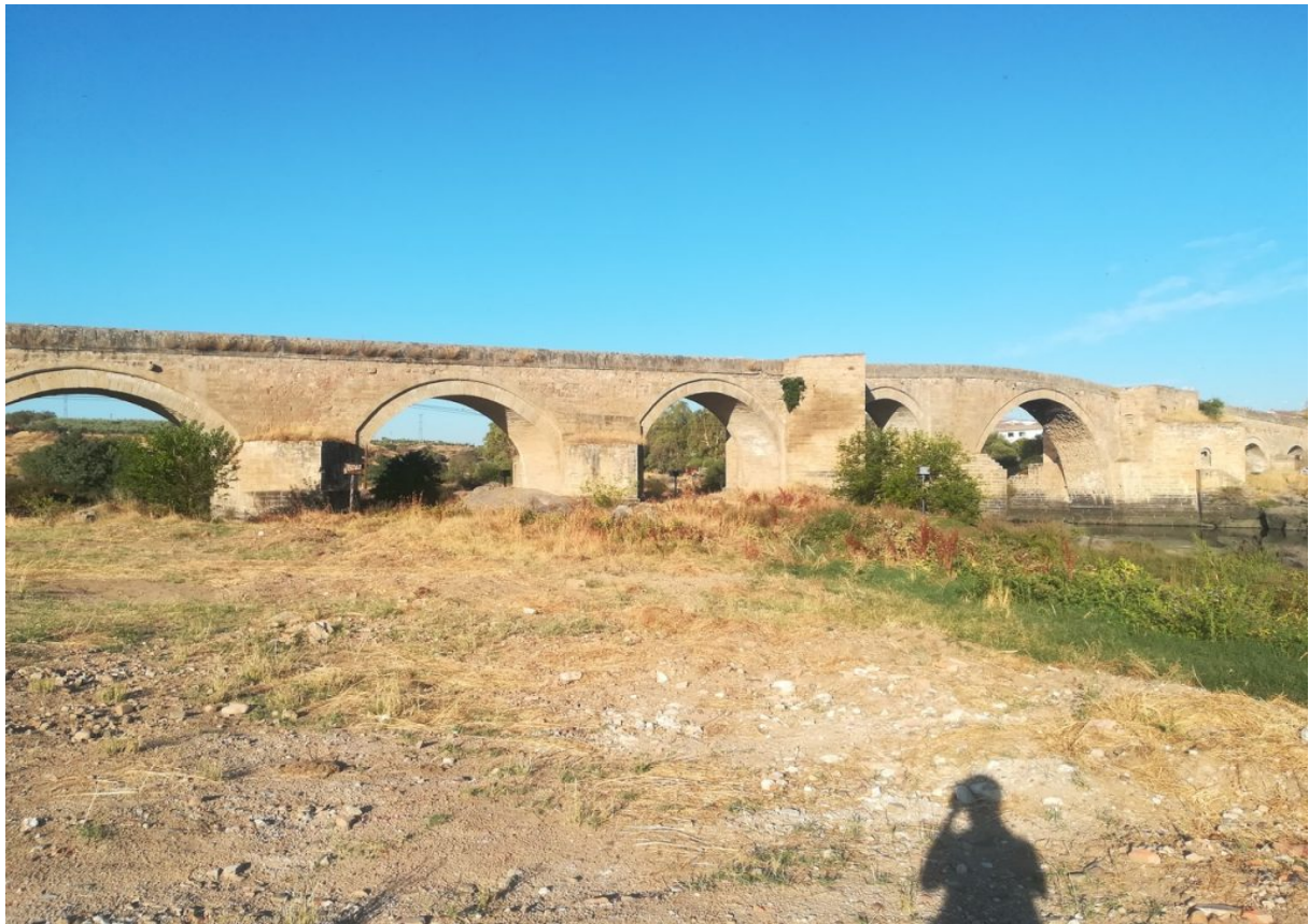
Pont sur le Tage à La Puente del Arzobispo.
