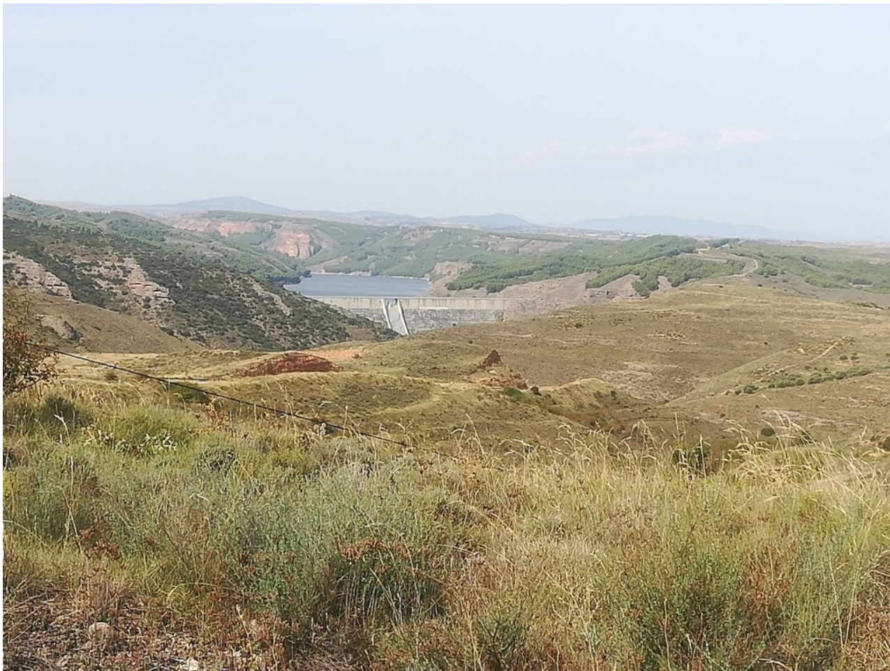
Le barrage de Torellas
