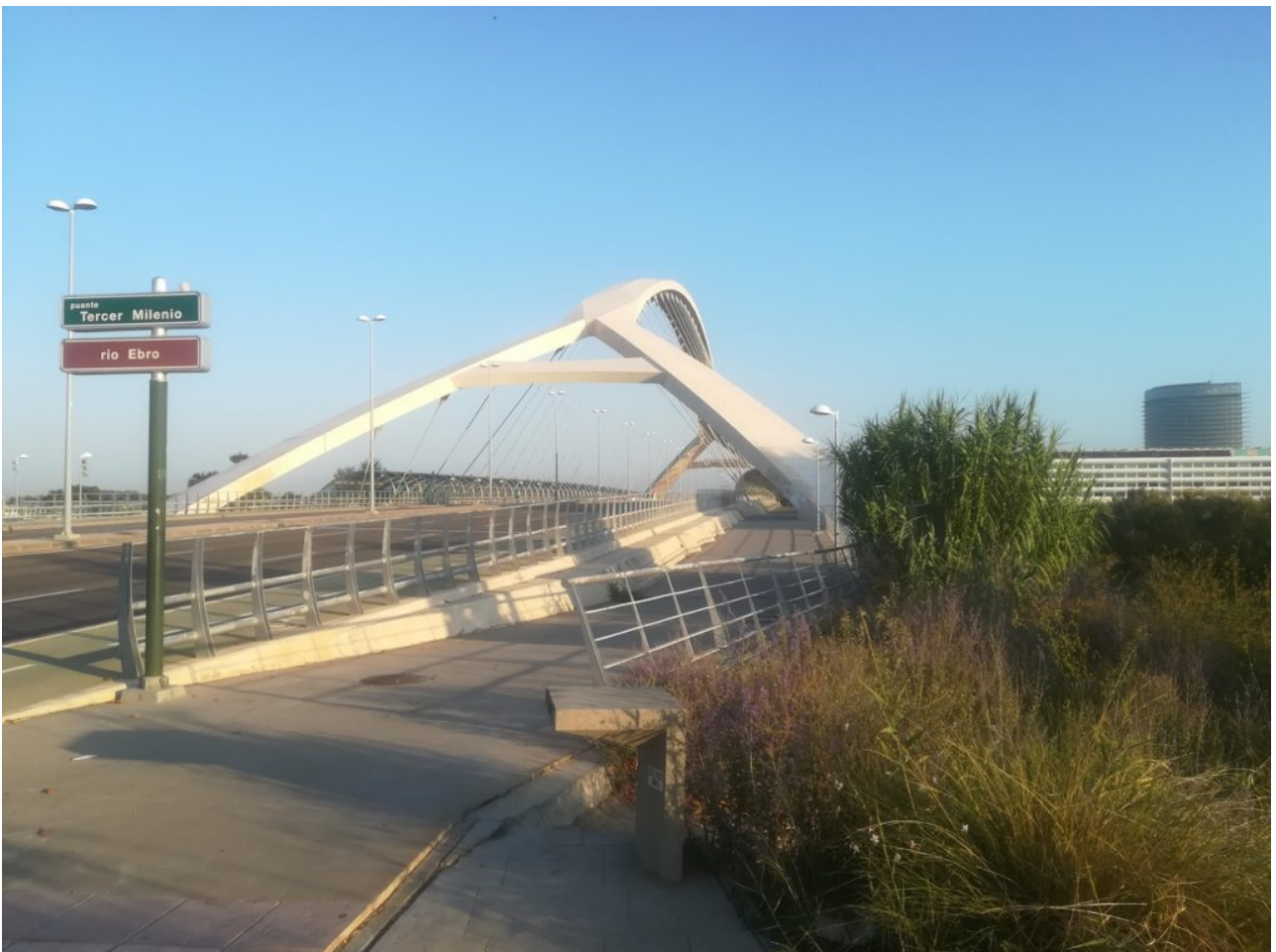
Pont sur l'Ebre en quittant Saragosse. Au fond, à droite, la tour de l'eau.
