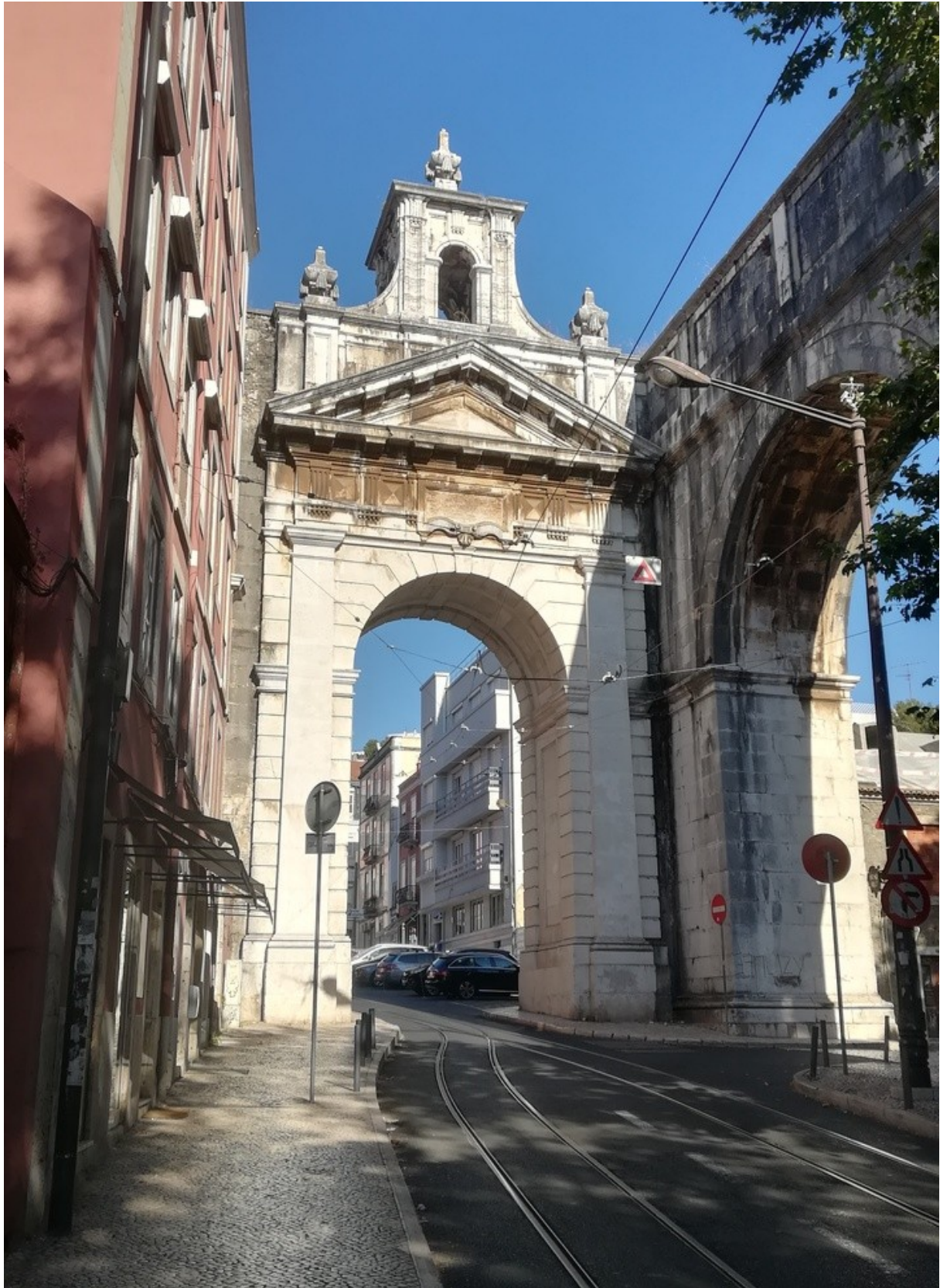
Porte de la ville supportant l'aqueduc.
