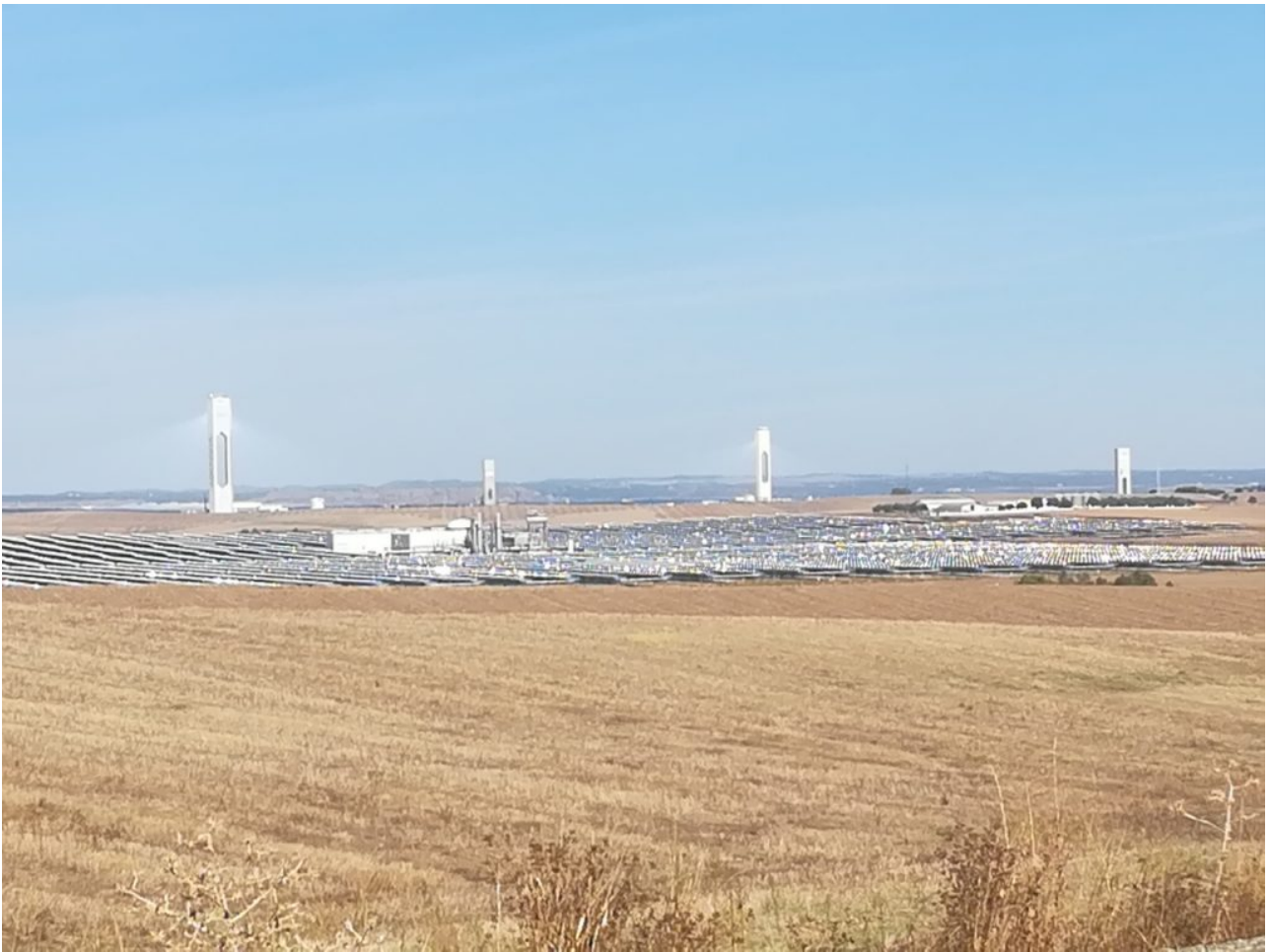
4 centrales solaires thermiques (je pense que ce sont 2 PS10 et 2 PS 20) près de Sanlucar la Mayor. De la poussière dans l'air rend la lumière convergente visible. Pour en savoir plus : https://fr.wikipedia.org/wiki/Abengoa_Solar https://fr.wikipedia.org/wiki/Centrale_solaire_PS10
