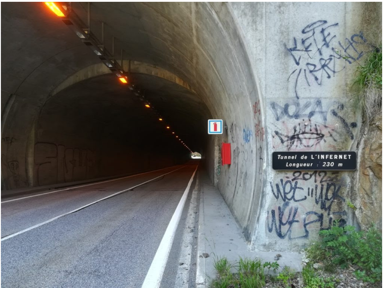
Le Tunnel de l'Infernet en remontant du Garcin à Freney d'Oisans.
