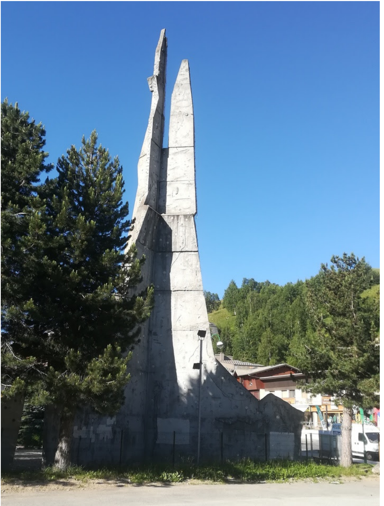
Le mur d'escalade artificiel des Deux Alpes.
