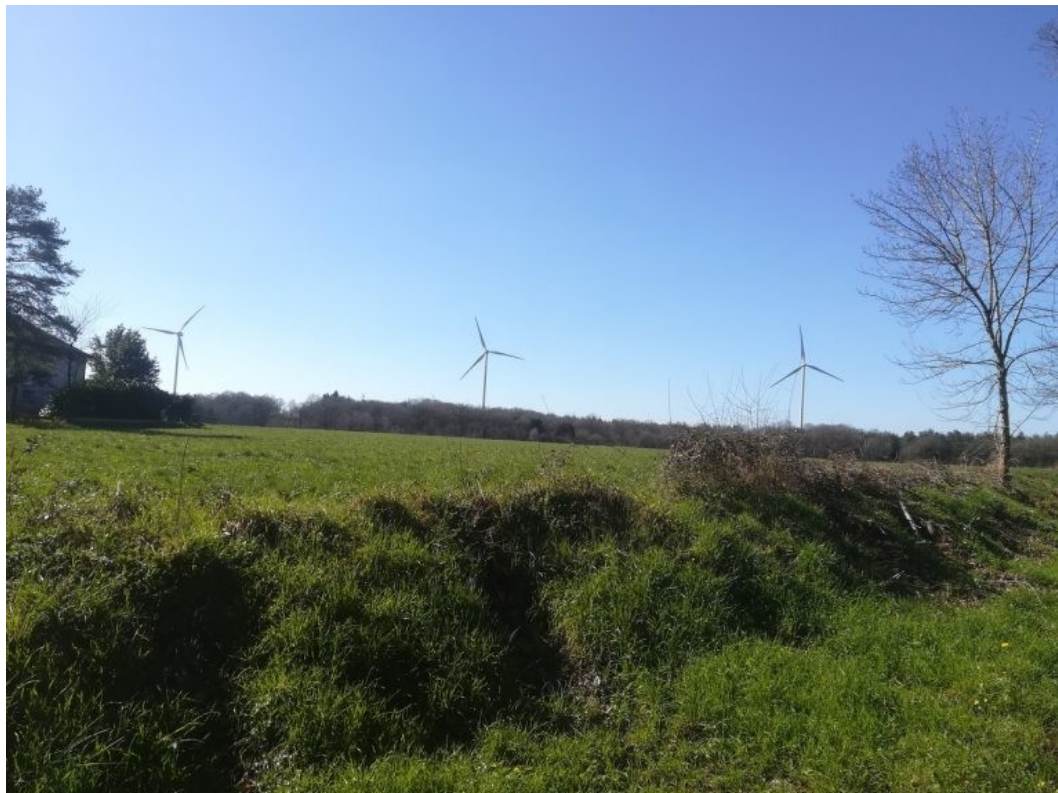
Les éoliennes de La Ferrière de Flée.
