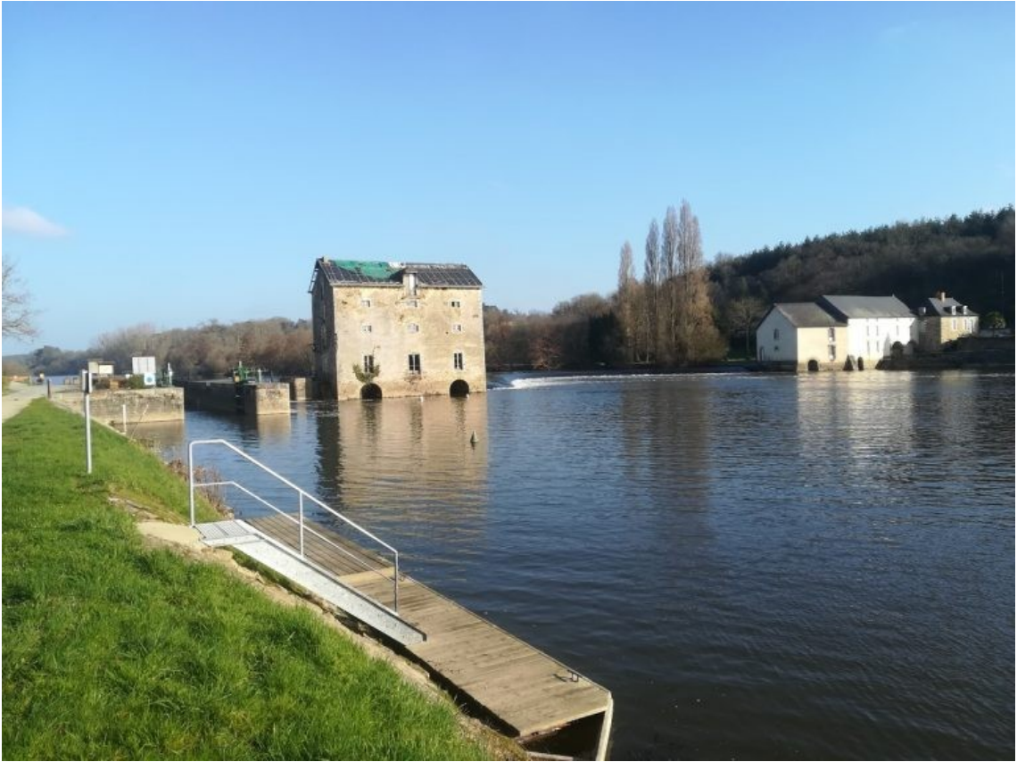
L'écluse de la Roche.
