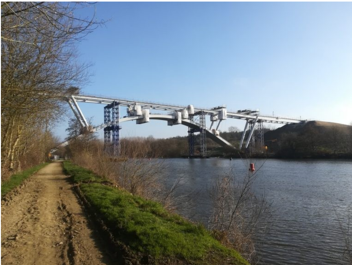
Le viaduc de contournement de Château-Gontier en cours de construction. Splendide ouvrage, superbe architecture pour un projet obsolète (de mon point de vue).
