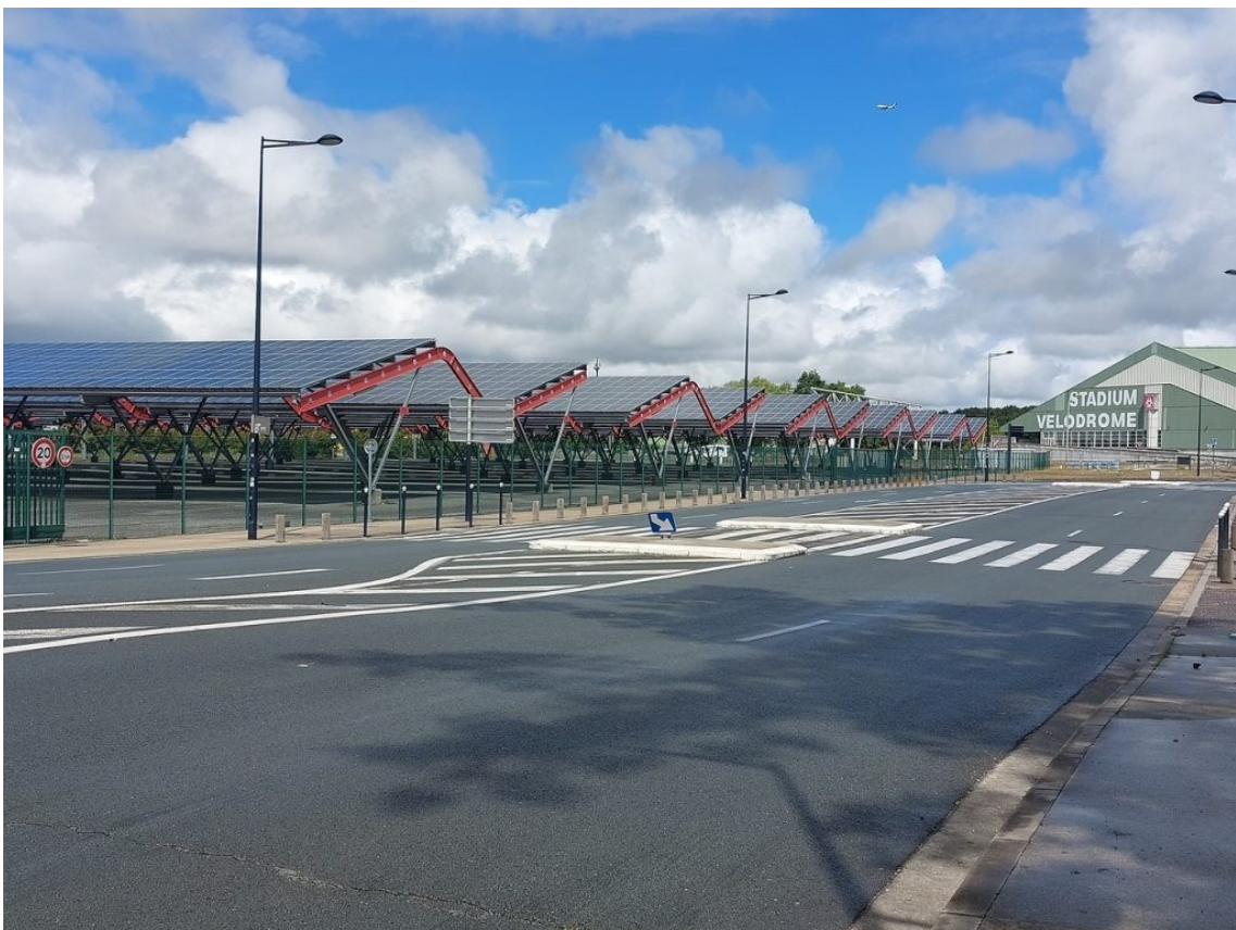
Les parkings couverts de panneaux photovoltaïques.
