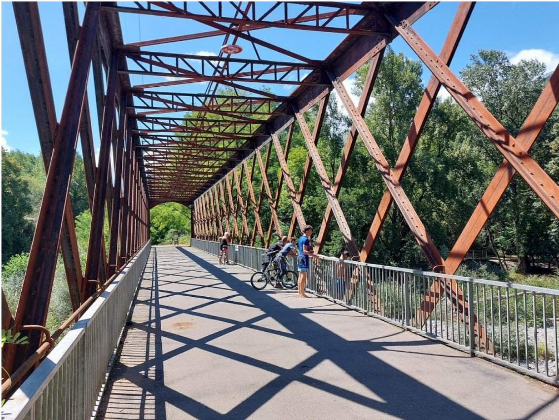
La véloroute Pierrefitte-Nestalas – Lourdes sur l'ancienne voie de chemin de fer, viaduc sur le gave de Pau.
