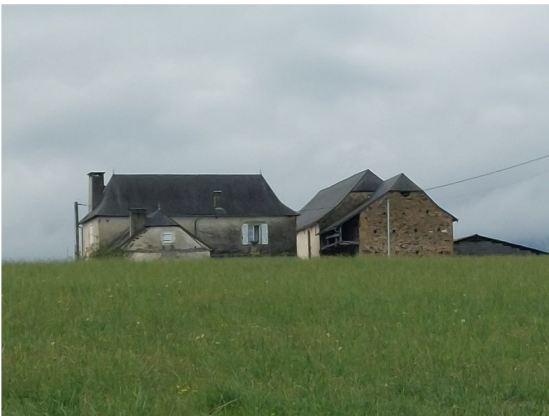
Ferme du Haut-Béarn, vallée du Soust.
