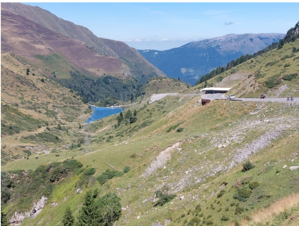
Sous la mongie, un petit réservoir (pour les canons à neige en hiver ?).
