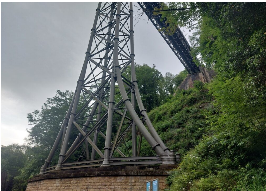
Le viaduc de Rouzat.
