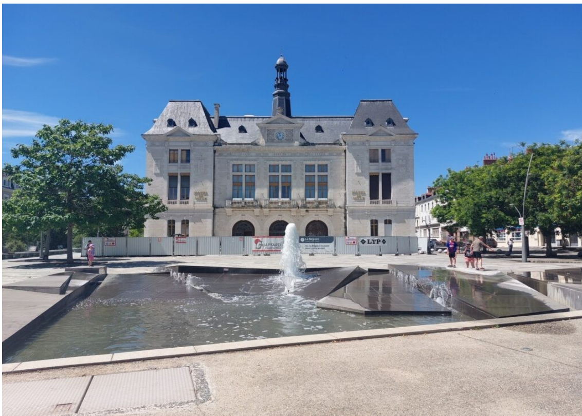
L'Hôtel de ville de Montluçon, boulevard de Courtais.
