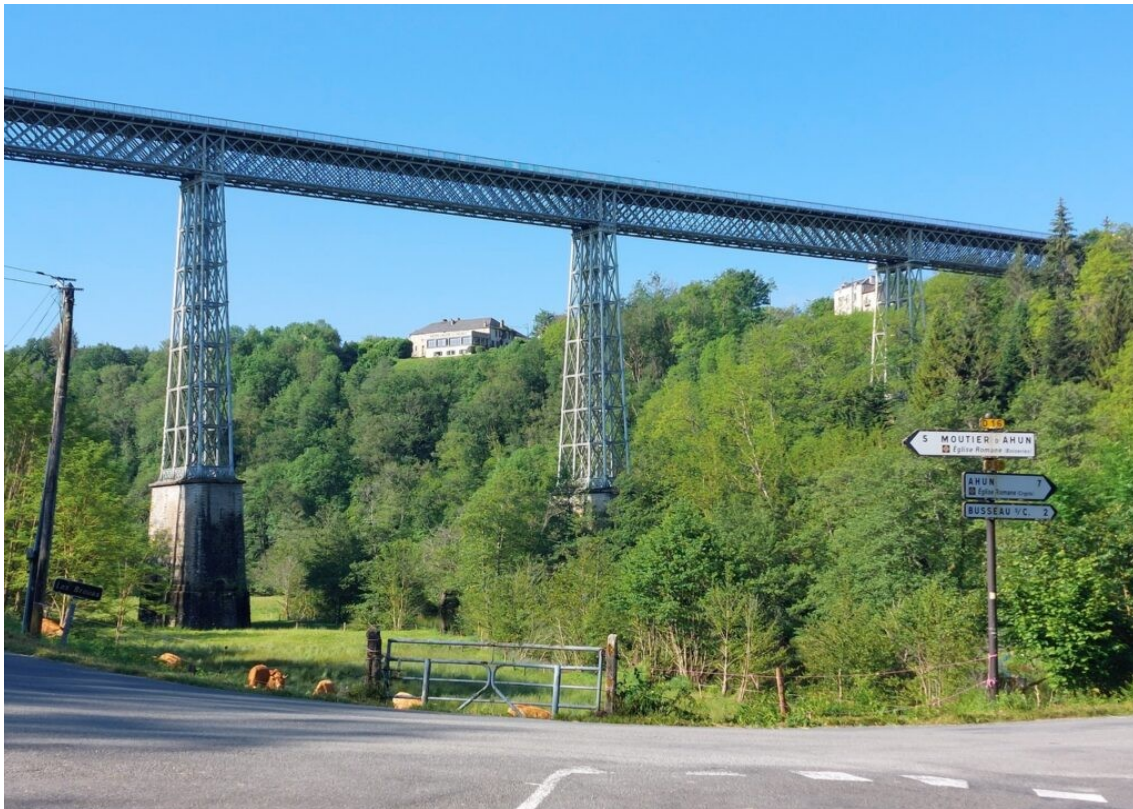
Le viaduc de Busseau sur Creuse.
