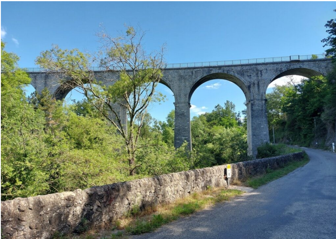
Viaduc d'une ancienne voie de chemin de fer.
