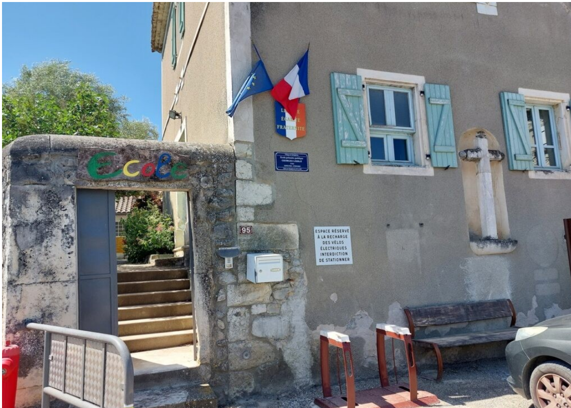
Bornes de recharge de vélos électriques devant l'école de Valvignères.
