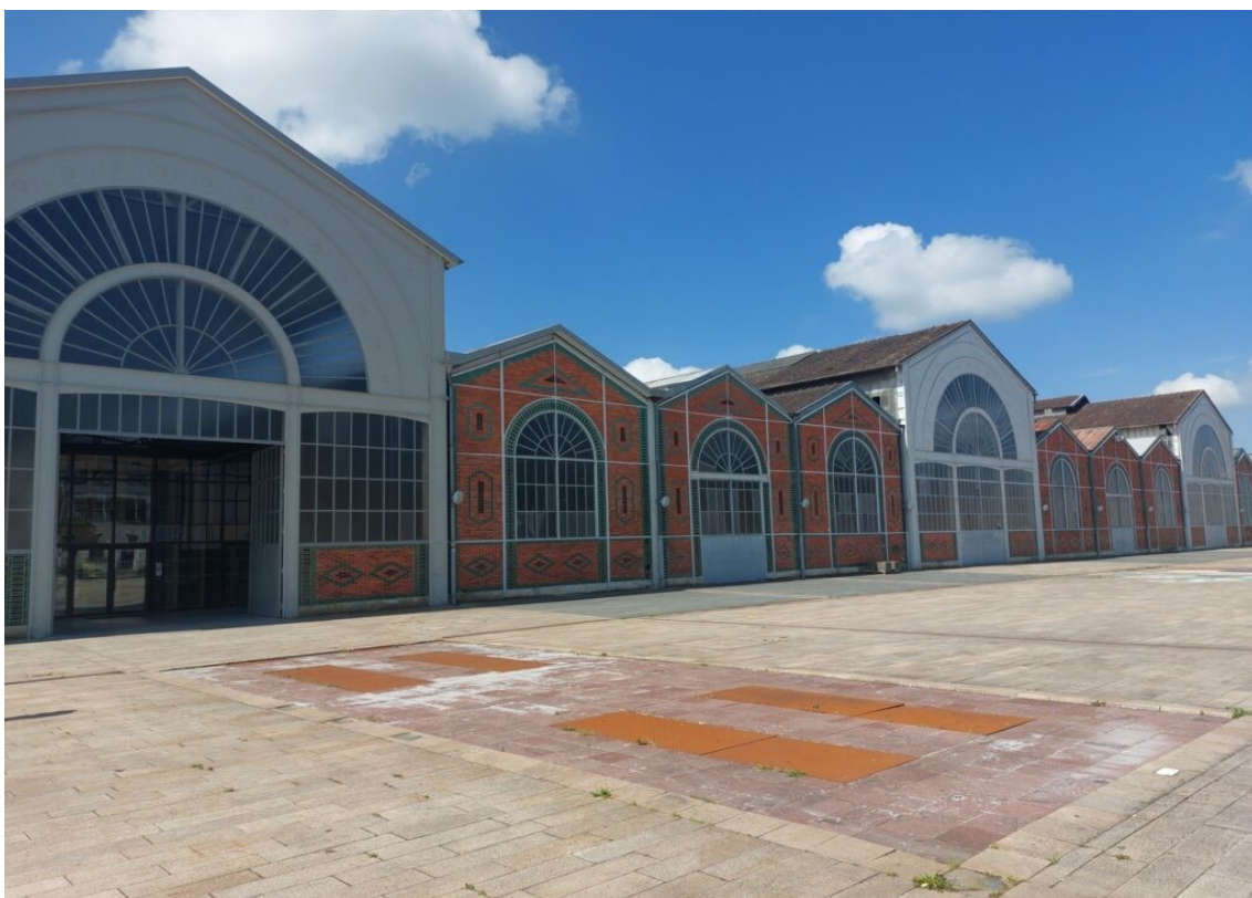
Le site de la SDV à Vierzon, aujourd'hui, c'est, en partie, un établissement du CNAM.
