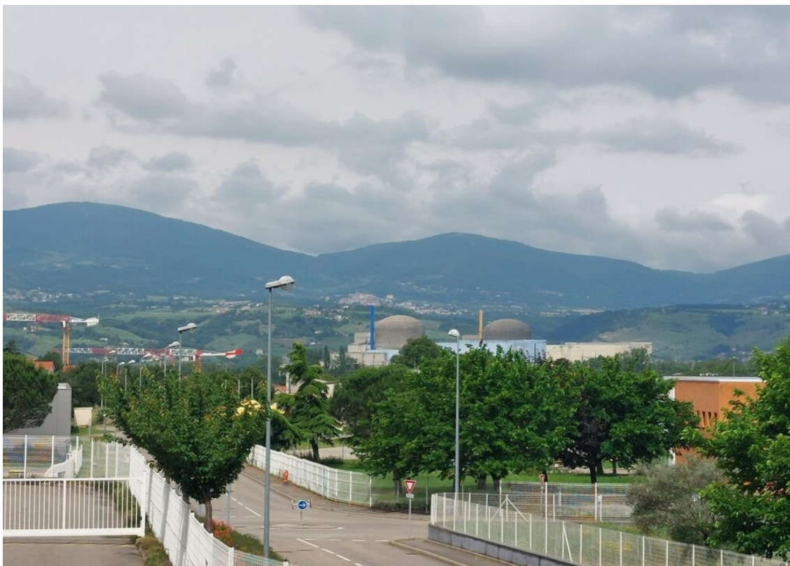
La centrale nucléaire de Saint Maurice l'Exil.
