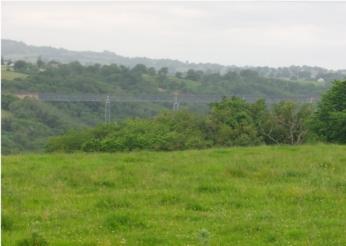
Le viaduc ferroviaire de la Double.
