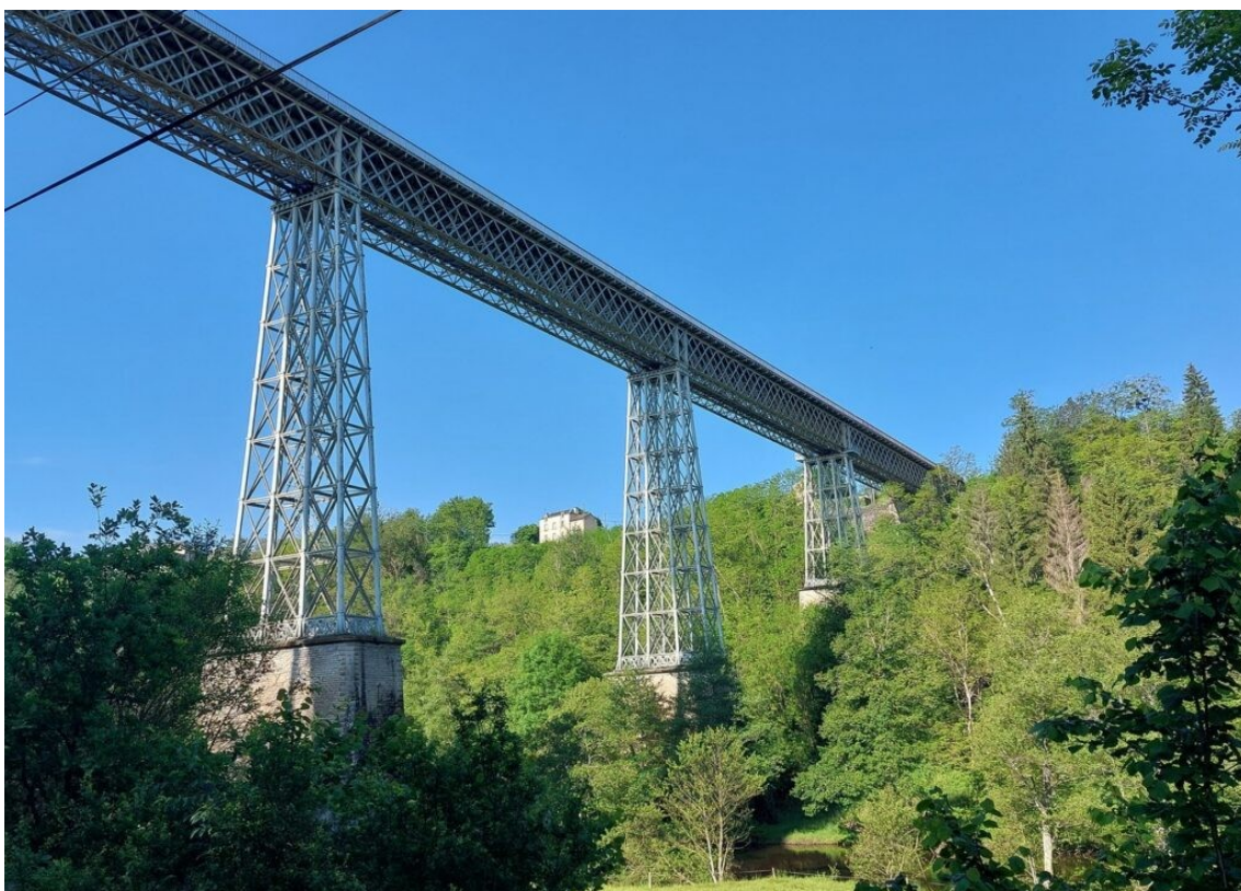
Le viaduc de Busseau sur Creuse.
