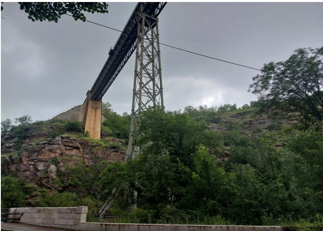
Le viaduc de Rouzat.
