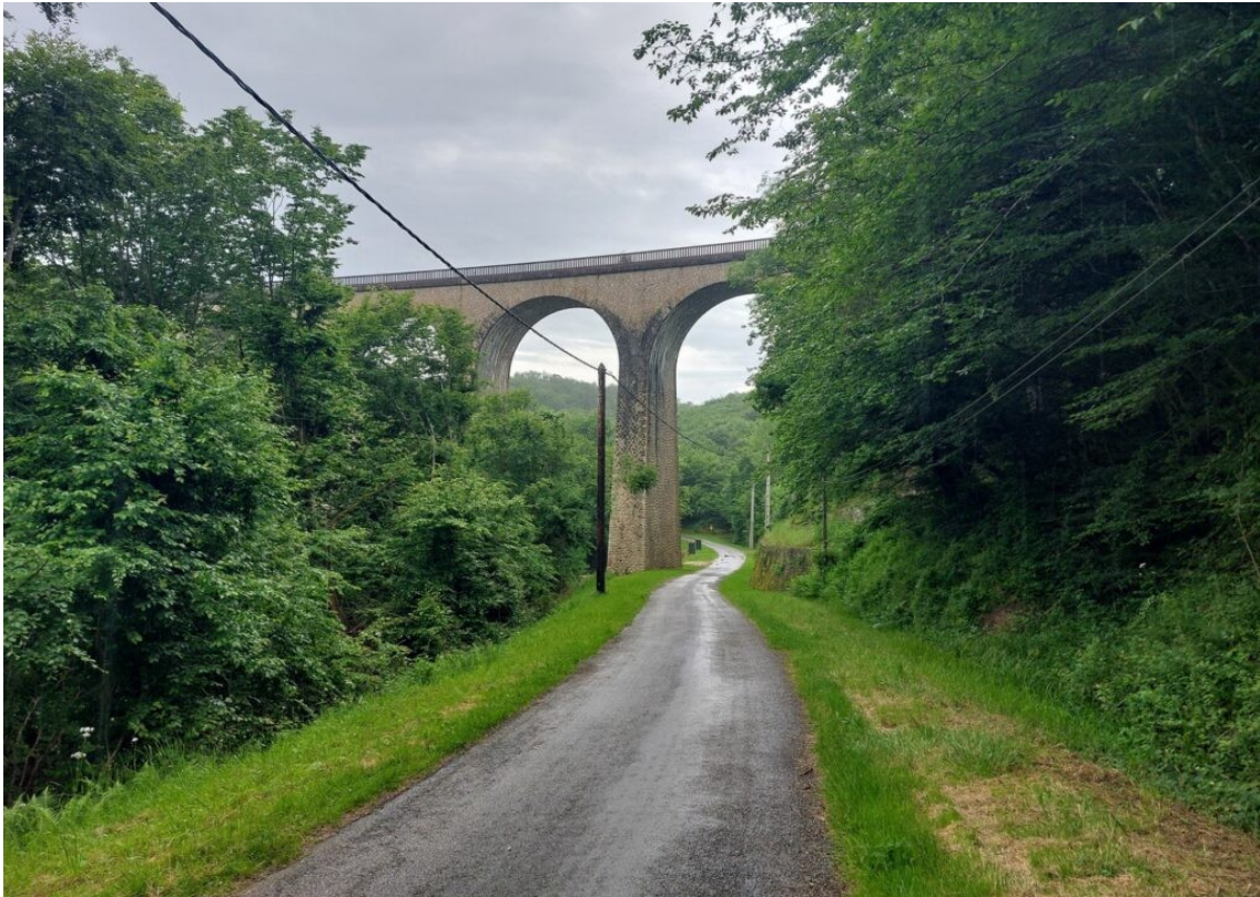
Le viaduc de la Perrière à Coustansouze.
