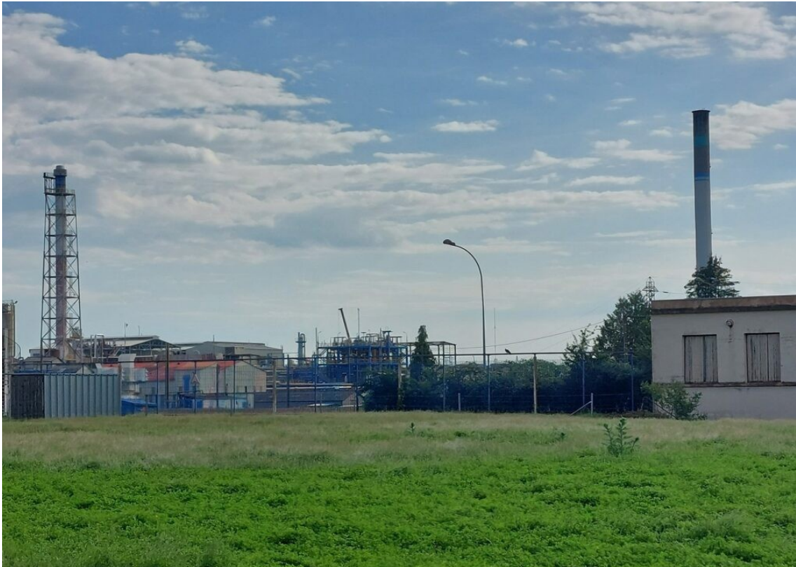
Grosse usine à Commentry. Non identifiée.
