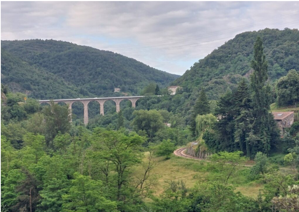
Viaduc routier sur le Doux (je suis passé dessus).
