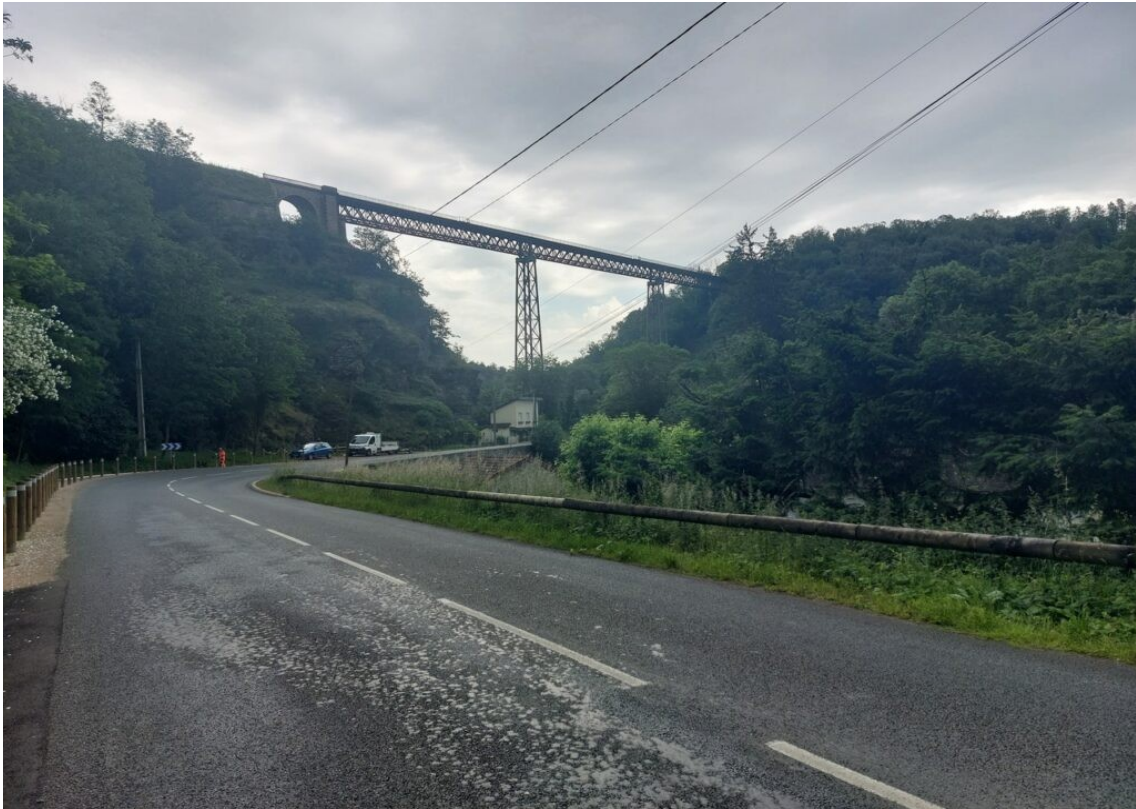
Le viaduc de Rouzat.
