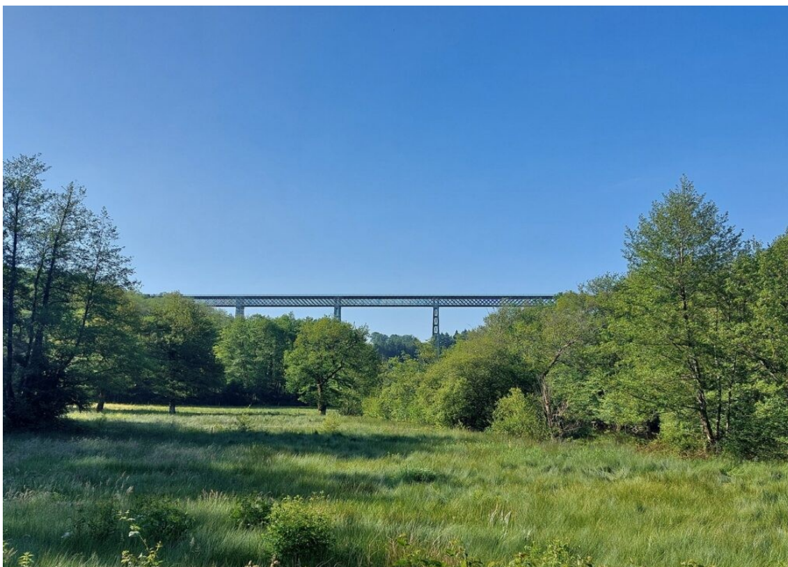
Le viaduc de Busseau sur Creuse.
