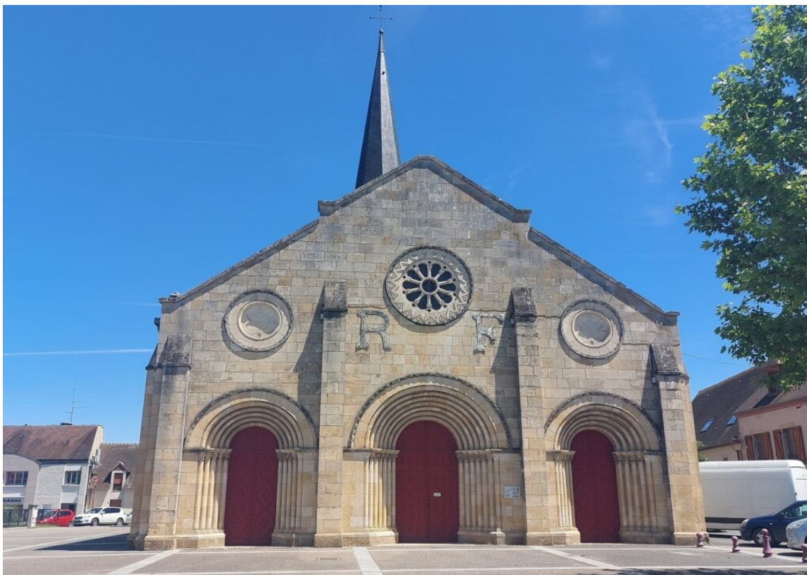
L'église de Domérat. Noter le RF sur la façade.
