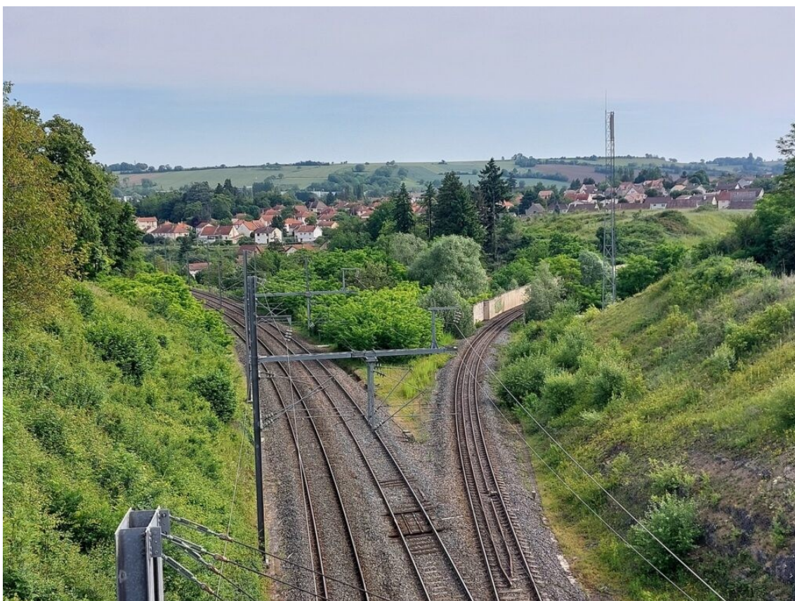
A droite bifurcation vers Roanne (Lyon), à gauche, la ligne vers Moulins (Nantes). Derrière, ligne venant de Gannat (Montluçon) et Vichy (Clermont-Ferrand). Saint Germain des Fossés est un noeud ferroviaire important.
