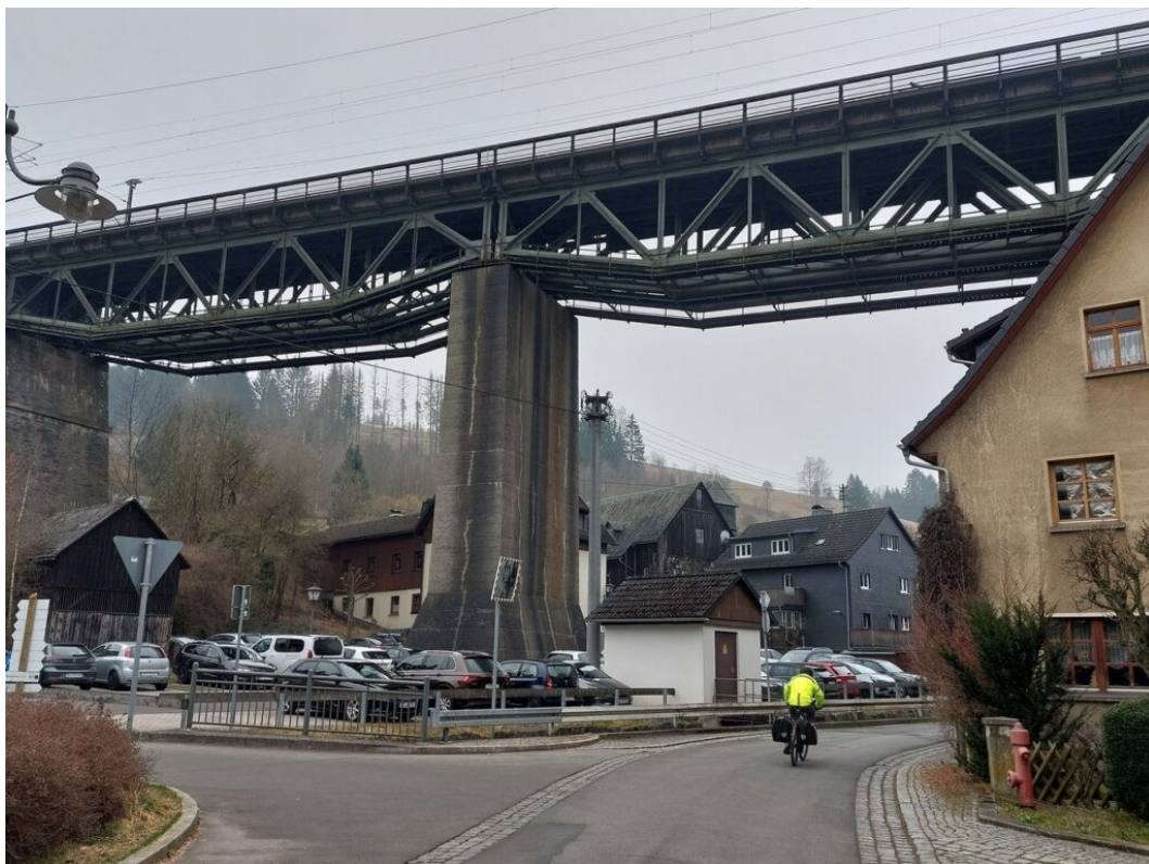
Viaduc de la voie ferrée à Ludwigsstadt. Autrefois, c'était la ligne Berlin-Münich, maintenant cette ligne passe par Erfurt et Coburg, plus à l'ouest. Mais un train passe toujours par Ludwigsstadt, c'est la ligne Nuremberg-Saalfeld, un train par heure (dans chaque sens) sans compter quelques rapides qui s'arrêtent à Ludwigsstadt.
