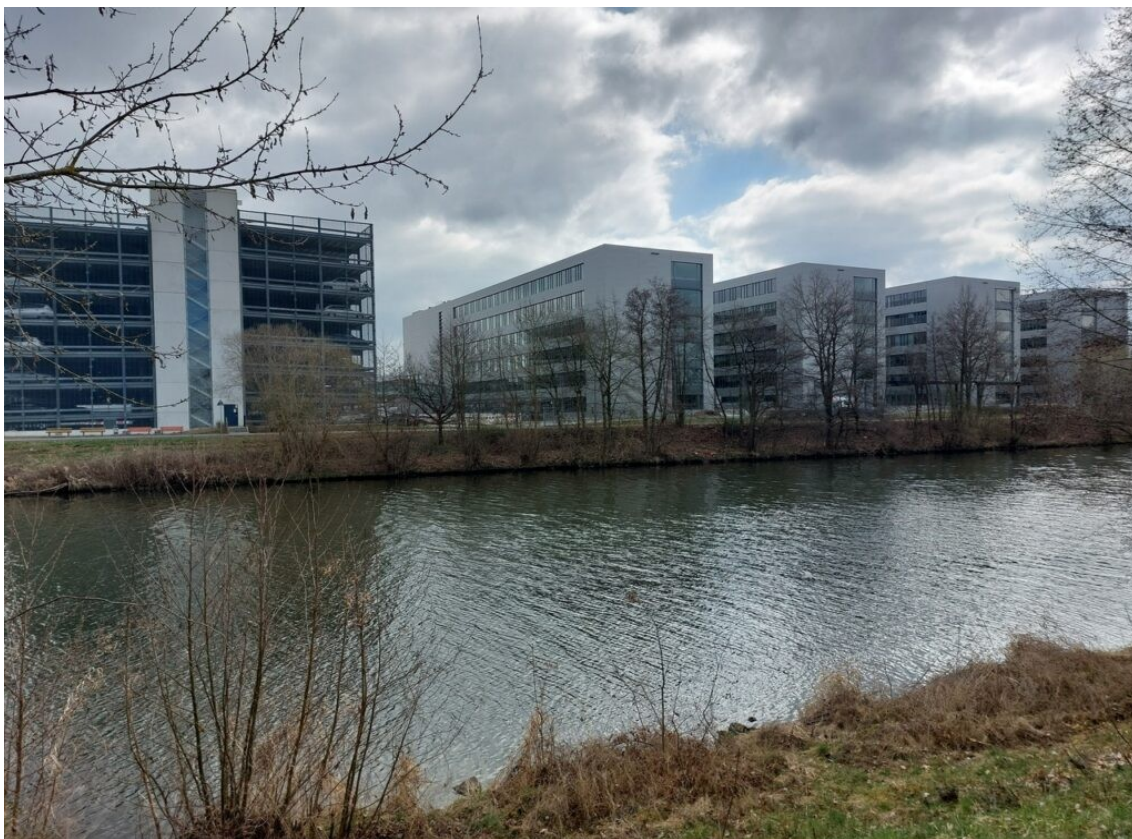
4 immeubles de bureaux et un parking aérien à Forchheim, le long du canal du Main au Danube.
