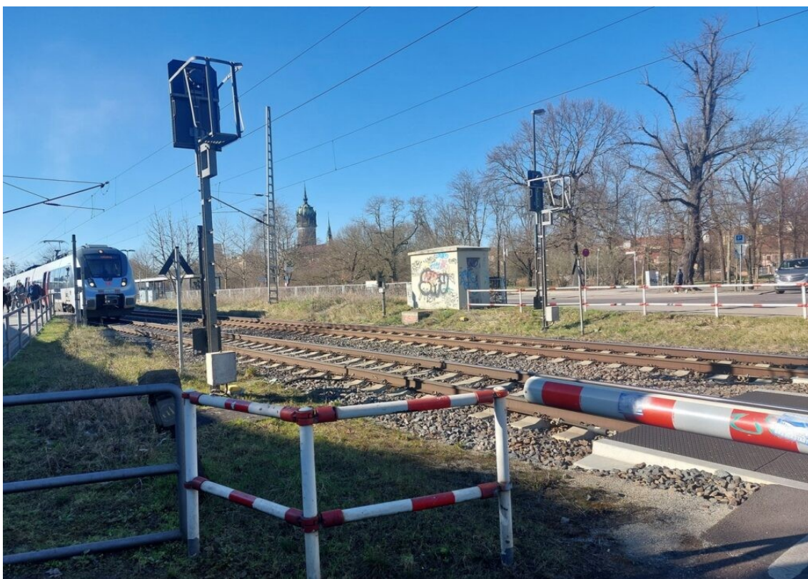
Passage à niveau piéton-vélo en gare de Wittemberg-Lutherstadt.
