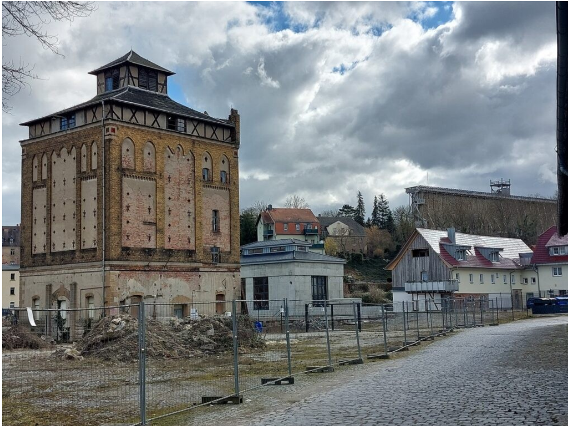
A gauche, l'ancien moulin de Bad Kösen, et à droite, au fond, l'espèce de mur est un bâtiment de graduation de la saumure. La graduation est un procédé industriel utilisé dans certaines salines pour augmenter la concentration en sel de la saumure par évaporation naturelle de l'eau. Celle-ci est alors exposée au vent sur une large surface dans des bâtiments spécialement conçus (majoritairement construit en bois sur la longueur).
