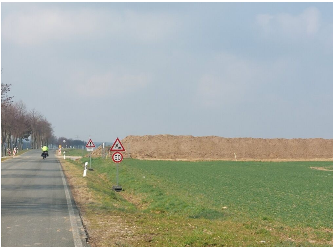
Lever de terre en quittant Etzdorf, probablement l'enterrement d'une canalisation (d'eau ? de gaz ?).
