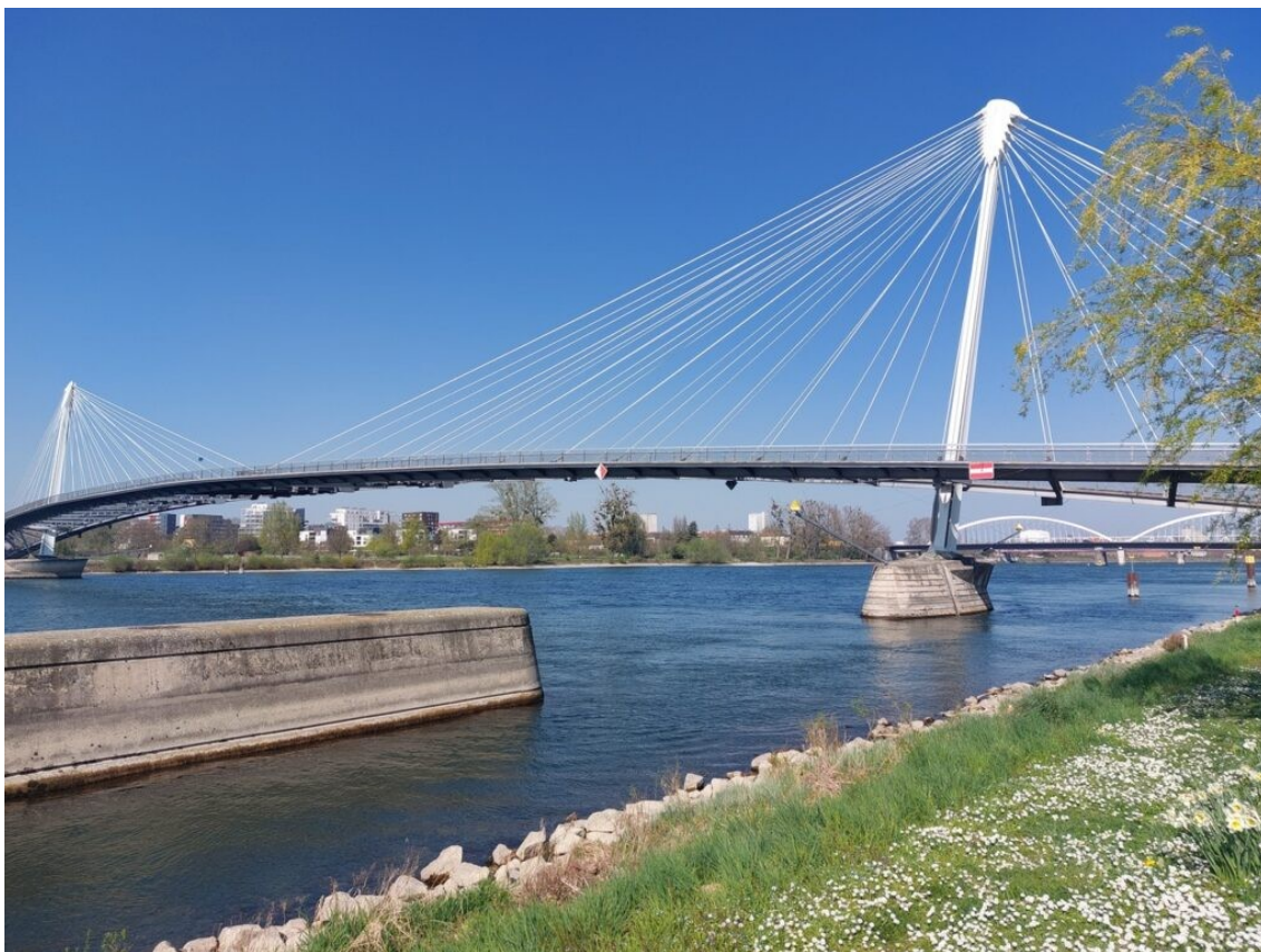
La passerelle Mimram ou passerelle des Deux Rives, passerelle pour piétons et cyclistes qui relie les deux parties du jardin des Deux Rives situées de chaque côté du Rhin, entre la ville française de Strasbourg et la ville allemande de Kehl.
