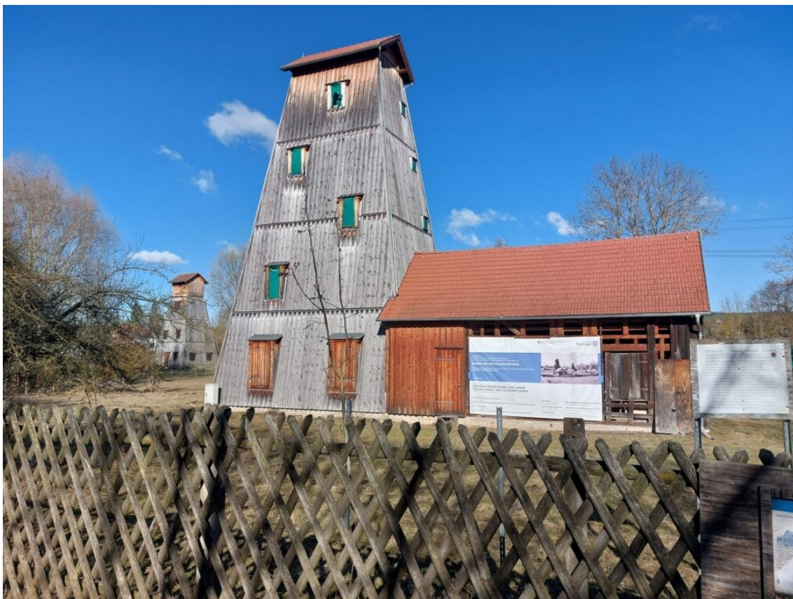
Plateforme de forage pour extraire de la saumure. La première extraction eut lieu entre 1893 et 1896 en creusant à 880 mètres de profondeur pour tirer une eau salée avec une concentration de 27 %.
