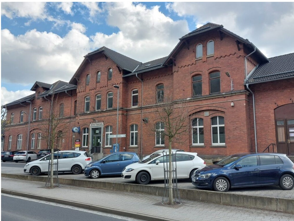
La gare de Probstzella (en Thuringe). C'était la gare frontière côté Est entre la RFA et la RDA. Côté Ouest, la gare frontière était Ludwigstadt (en Bavière), nous y passerons demain.
