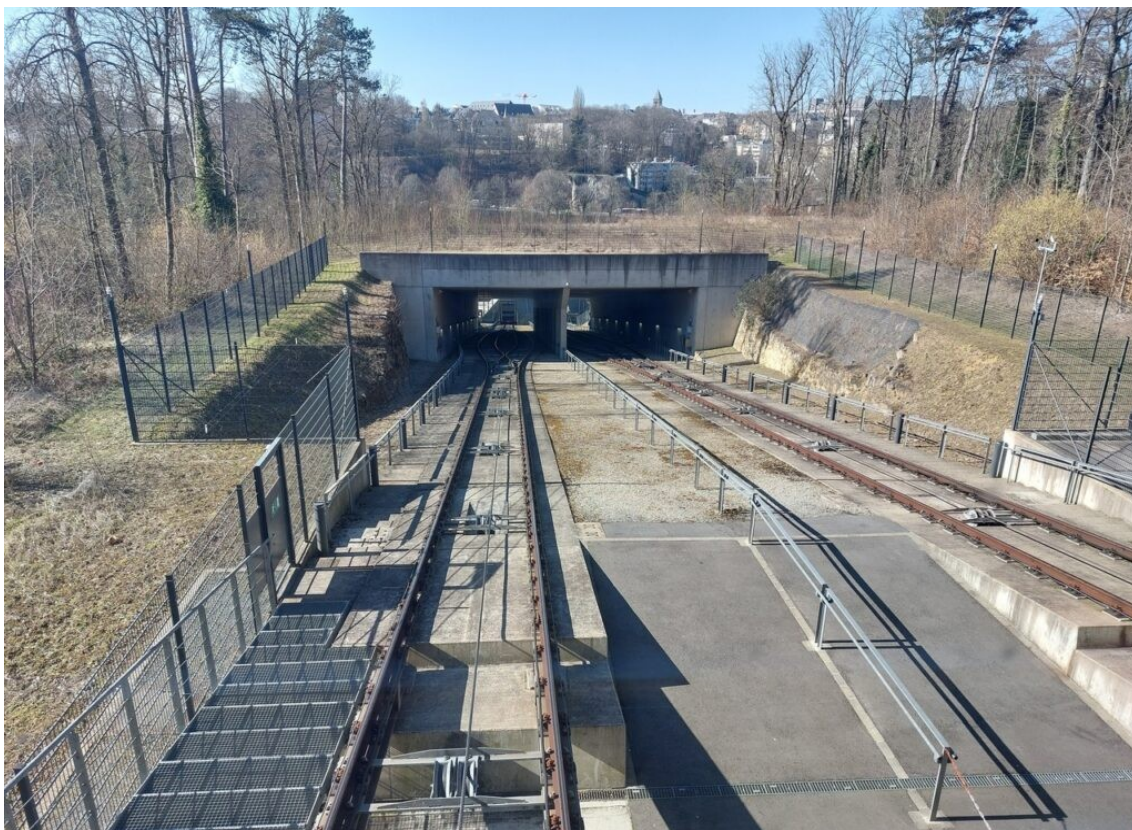
Le funiculaire de Pafendal pour descendre du pont de la Grande Duchesse Charlotte à la gare ferroviaire de Pfaffenhalt-Kichberg.
