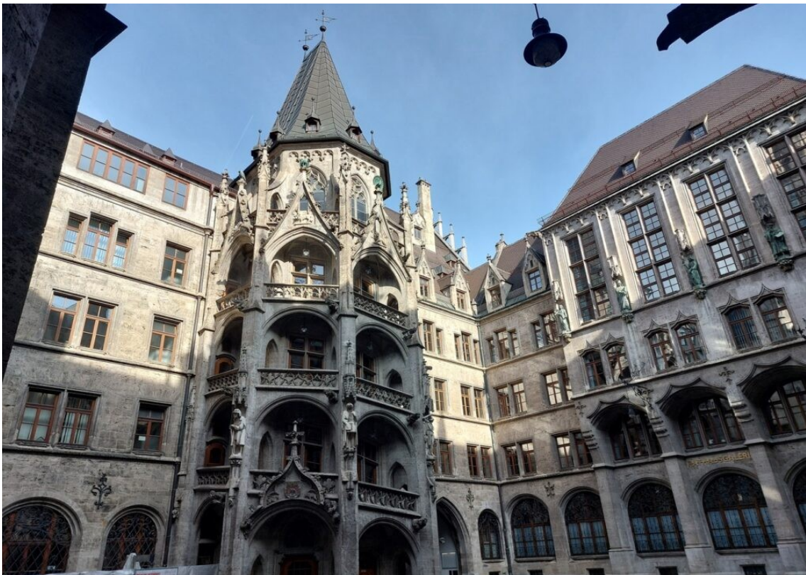
La cour intérieure de l'Hôtel de Ville.
