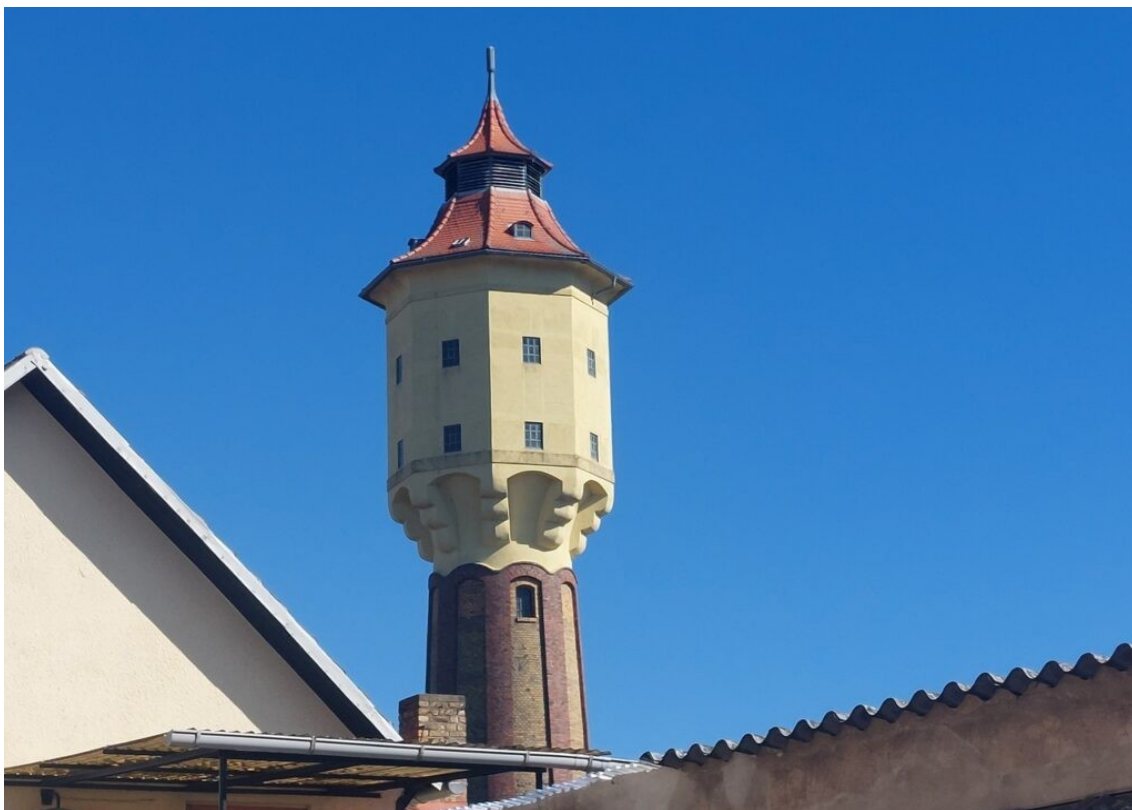
Château d'eau de Treuenbrietzen.
