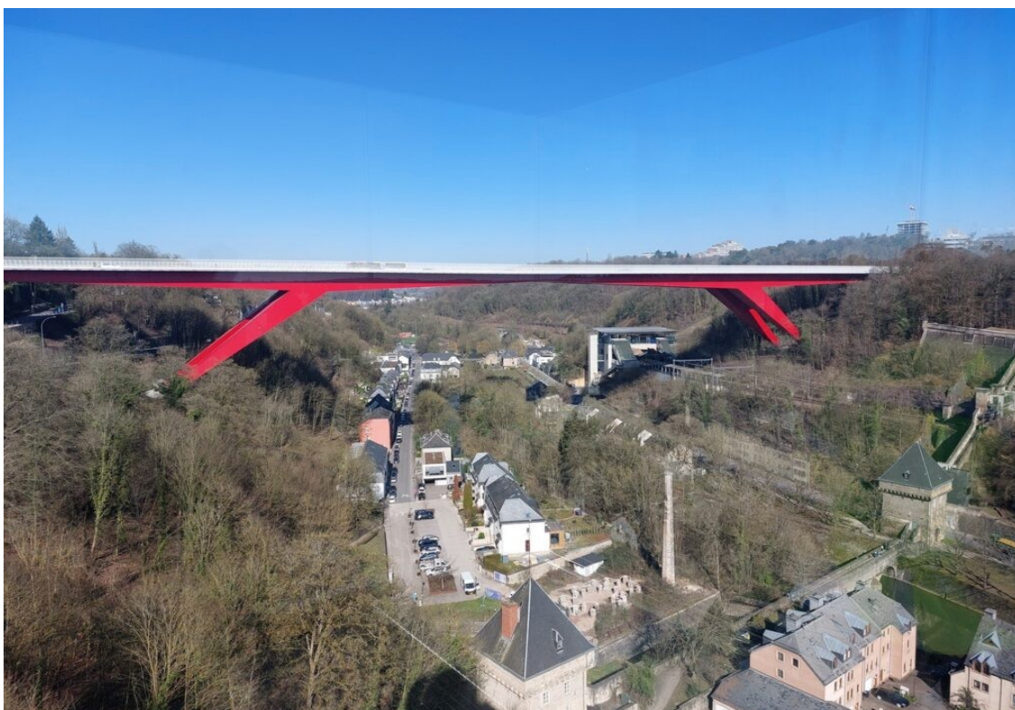
Le pont de la Grande Duchesse Charlotte au-dessus de la gare de Pfaffenhalt-Kichberg, vu depuis l'ascenseur de Pfaffenthal.
