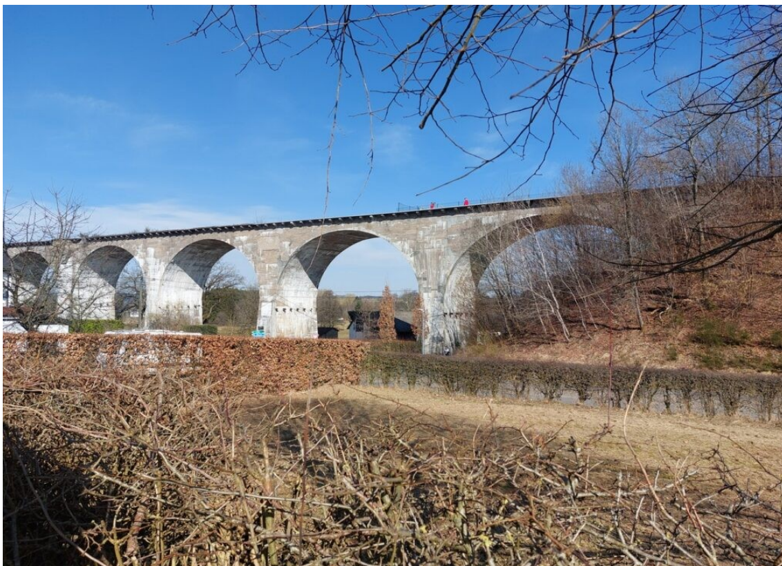
Le viaduc de Born construit en 8 mois de mars à novembre 1916, viaduc désaffecté aujourd'hui.
